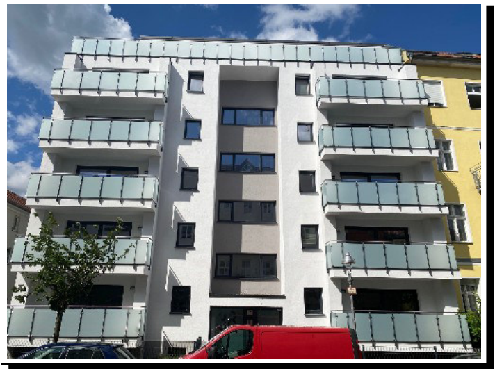
14199 Berlin; Misdroyerstr. 38 Kernsanierung eines Mehrparteienwohnhauses
